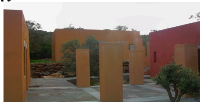
Ενδοδαπέδια Θέρμανση σε Βίλλα με Studios στην Αίγινα
