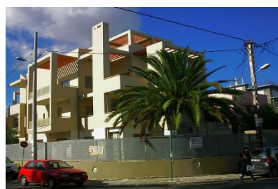
Ψύξη & Θέρμανση με σύστημα VRF DAIKIN σε πολυτελές κτήριο στη Φιλοθέη
